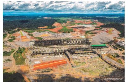
工事が終了したダム湖貯水・稼働を待つばかりのペロモンチ水力発電所
